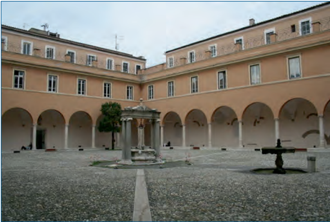
VISTA DEL CHIOSTRO
